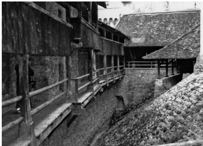
Photo VII : Château de Chillon : une des cours intérieures (Coll. P.E. LAGNEAU)
